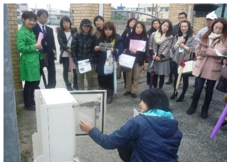
防災ボックスの説明の様子
