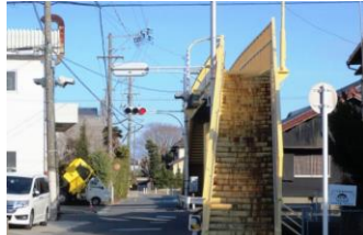
③伊福歩道橋付近 見通しが悪く歩道橋を自転車が使えないた め、東西の自転車や車の飛び出しに注意。
